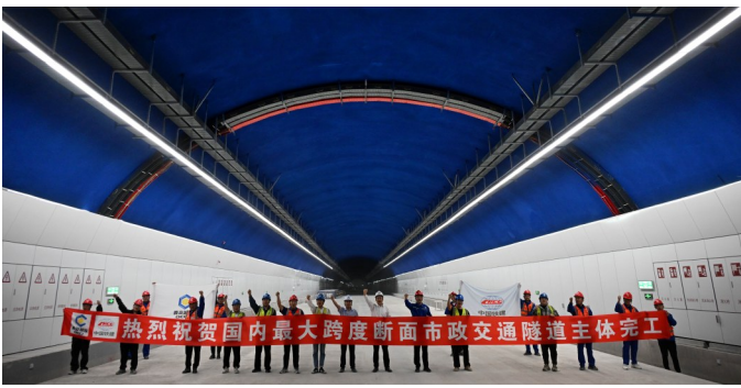
9月22日,中铁十四局建设者庆祝唐山路隧道主体完工。9月22日,青银高速公路增设唐山路互通及连接线工程唐山路隧道主体正式完工,全面进入隧道路面与装饰施工阶段。据介绍,该隧道全长1551米,双向双洞8车道,最大开挖跨度31.8米,最大开挖断面447.62平方米,是我国目前最大跨度断面市政交通隧道。(新华社记者 李紫恒 摄)
